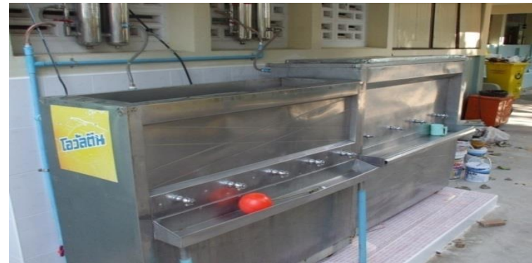
ถังน้ำเย็นบำบัดกรีตะกัว
