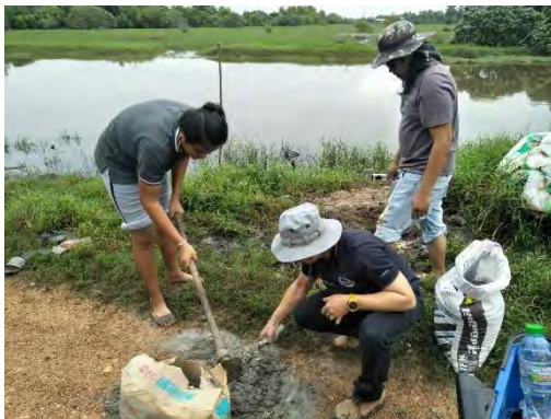
ก) การติดตั้งเครื่องวัดค่าความเค็ม น้ำฝนอัตโนมัติ บริเวณคลองตะโหนดรอบ
